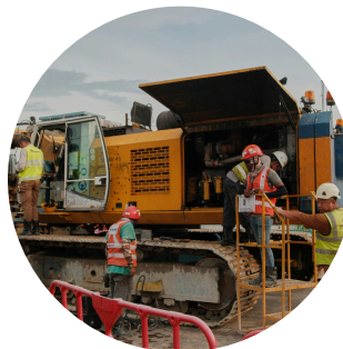
OBRAS DE INFRAESTRUCTURA
